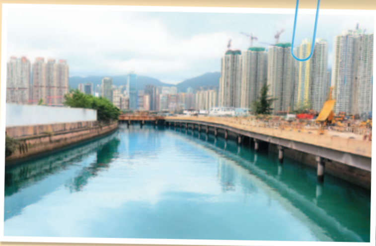
啟德明渠改善工程 Improvement to Kai Tak Nullah
